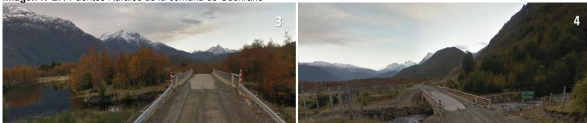
Imagen N°27: Puentes Rurales de la comuna de Cochrane
