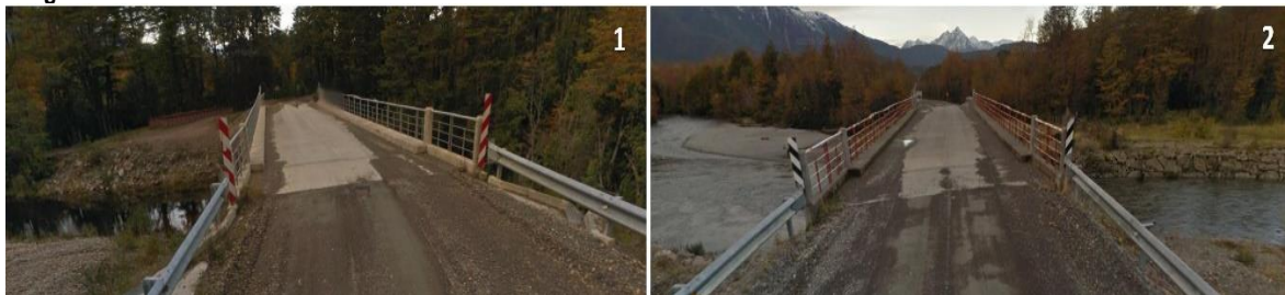
Imagen N°26: Puentes Rurales de la comuna de Cochrane
