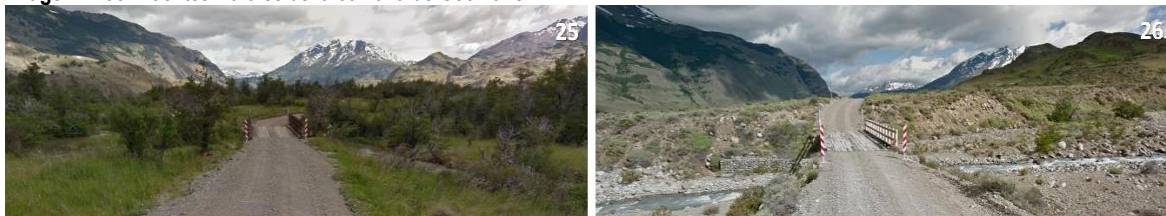
Imagen N°38: Puentes Rurales de la comuna de Cochrane
