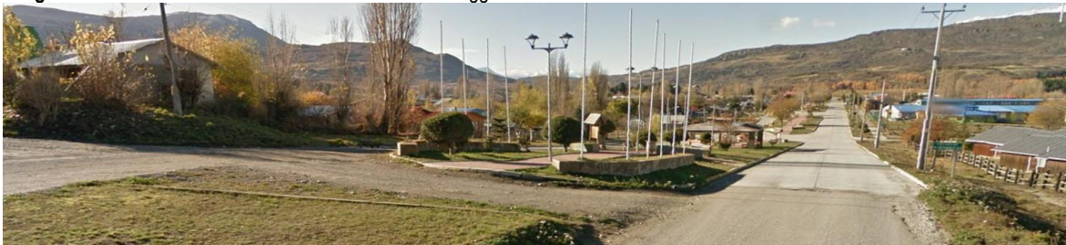
Imagen N°12: Acceso Sur a Cochrane AV. Bernardo O'Higgins
