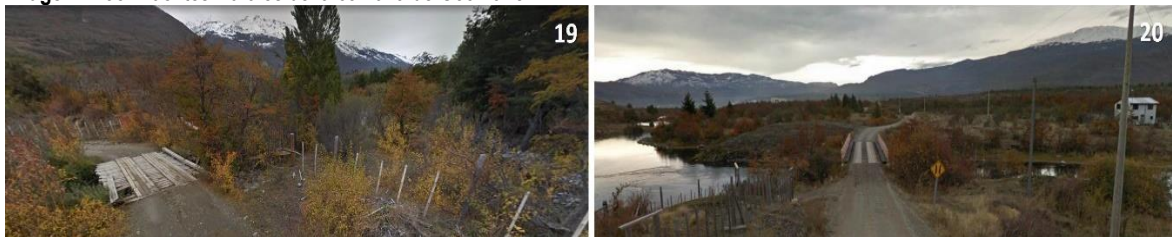
Imagen N°35: Puentes Rurales de la comuna de Cochrane
