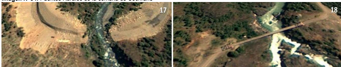
Imagen N°34: Puentes Rurales de la comuna de Cochrane
