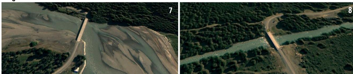
Imagen N°29: Puentes Rurales de la comuna de Cochrane
