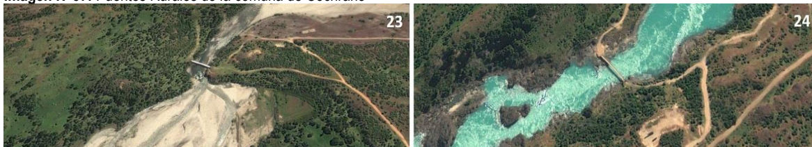
Imagen N°37: Puentes Rurales de la comuna de Cochrane
