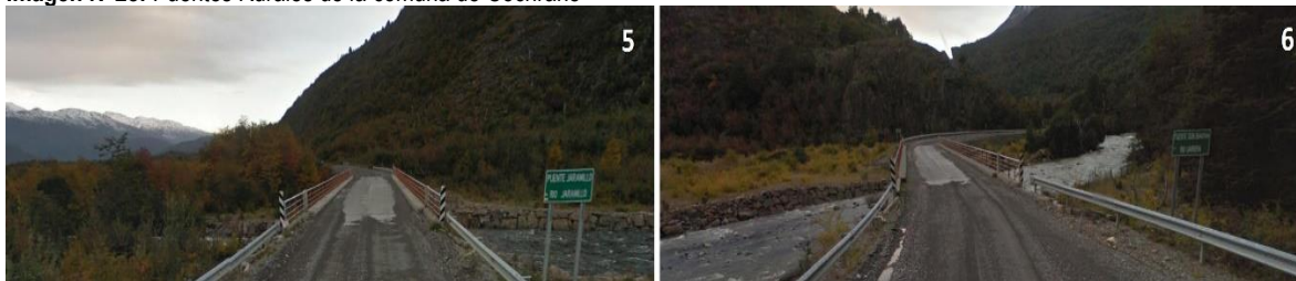
Imagen N°28: Puentes Rurales de la comuna de Cochrane
