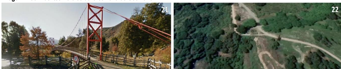
Imagen N°36: Puentes Rurales de la comuna de Cochrane
