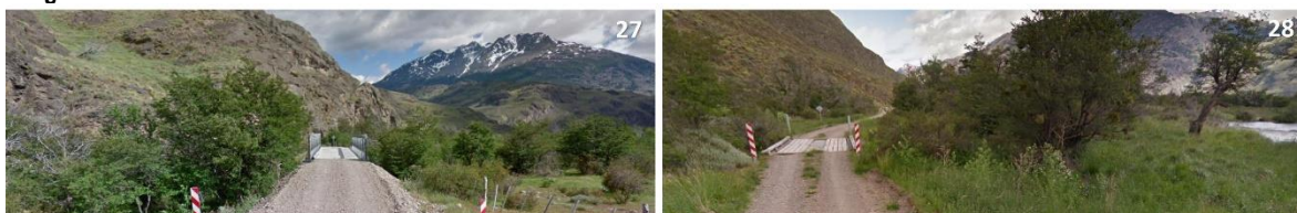
Imagen N°39: Puentes Rurales de la comuna de Cochrane
