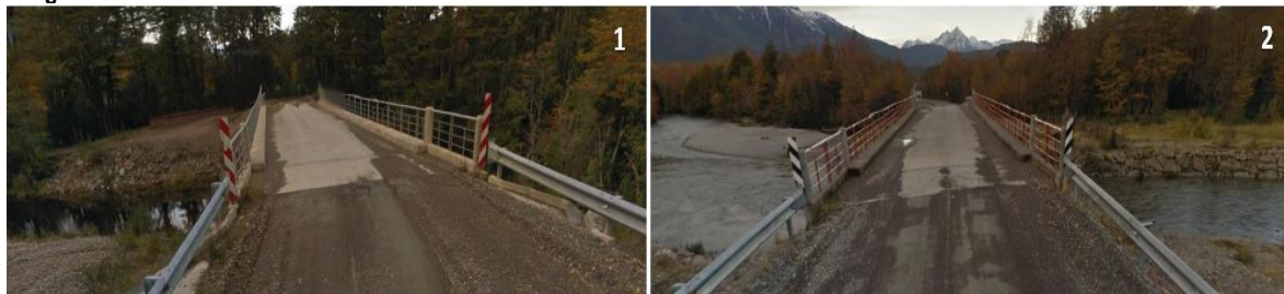
Imagen N°26: Puentes Rurales de la comuna de Cochrane
