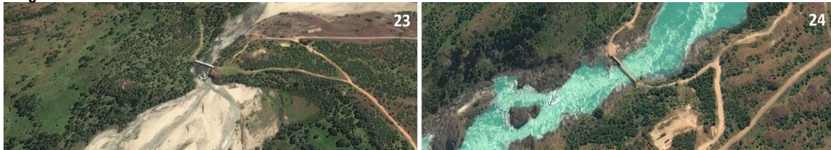
Imagen N°37: Puentes Rurales de la comuna de Cochrane
