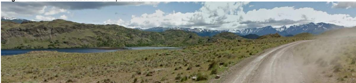
Imagen N°23: Rutas rurales Cochrane sin pavimentar
