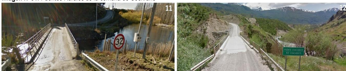
Imagen N°31: Puentes Rurales de la comuna de Cochrane
