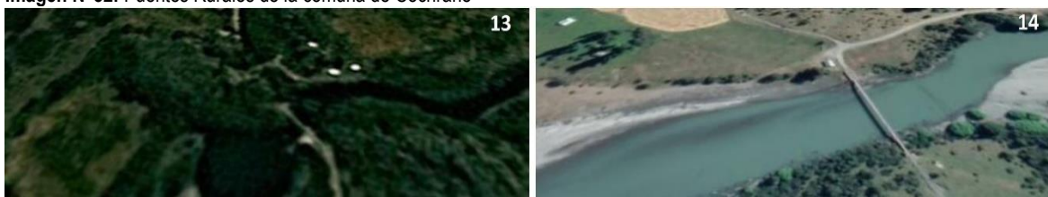
Imagen N°32: Puentes Rurales de la comuna de Cochrane
