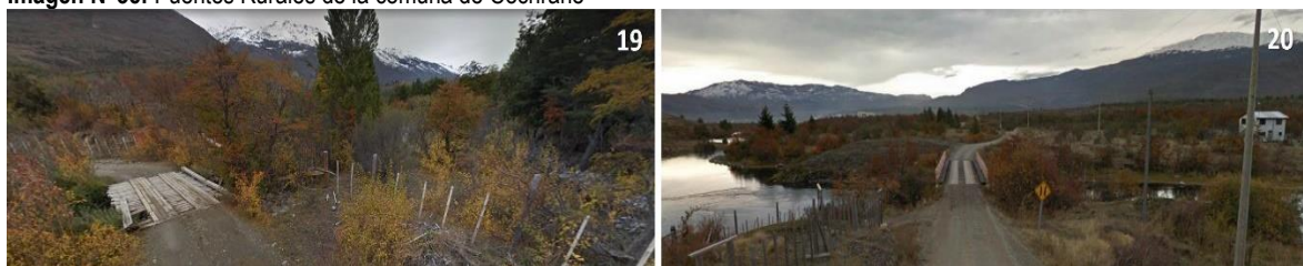
Imagen N°35: Puentes Rurales de la comuna de Cochrane
