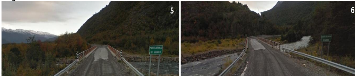
Imagen N°28: Puentes Rurales de la comuna de Cochrane
