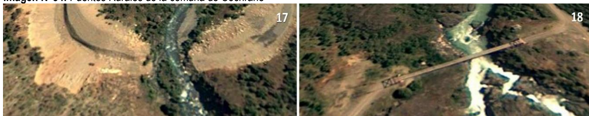
Imagen N°34: Puentes Rurales de la comuna de Cochrane
