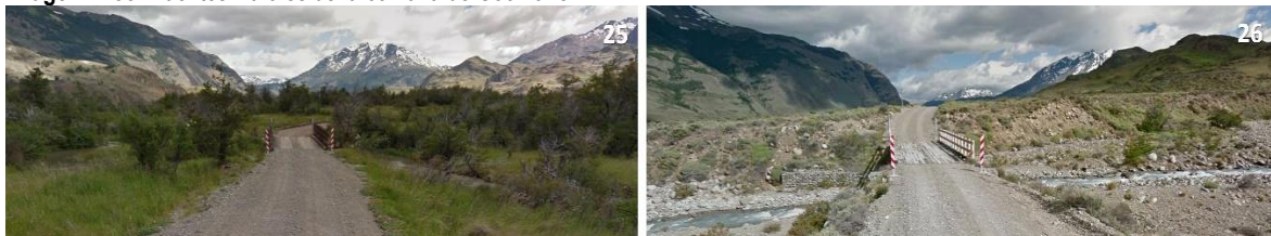
Imagen N°38: Puentes Rurales de la comuna de Cochrane
