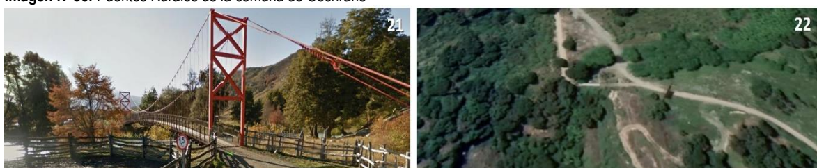
Imagen N°36: Puentes Rurales de la comuna de Cochrane
